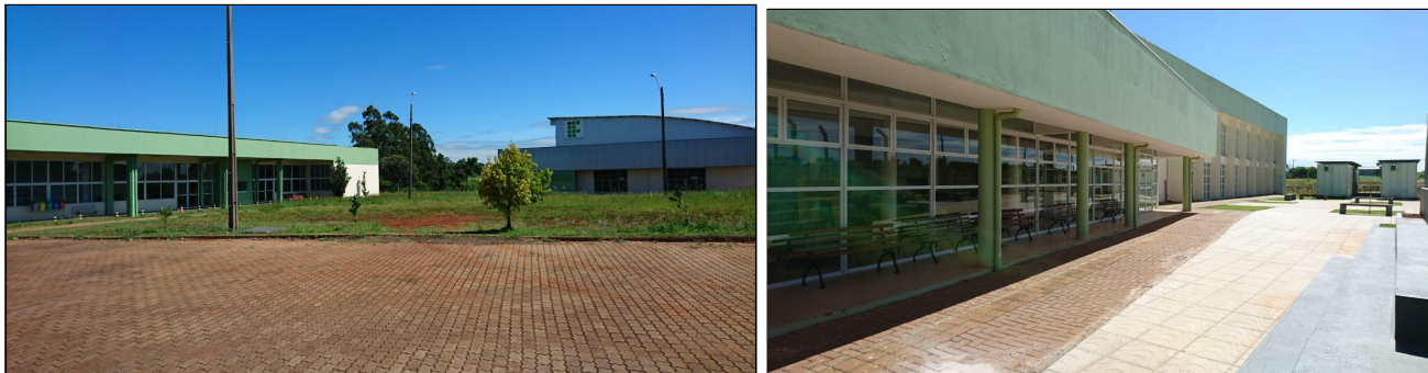
Fotos 21 e 22 - Vista Panorâmica do Refeitório e do Ginásio e Vista da Biblioteca Campus Santa Rosa.
