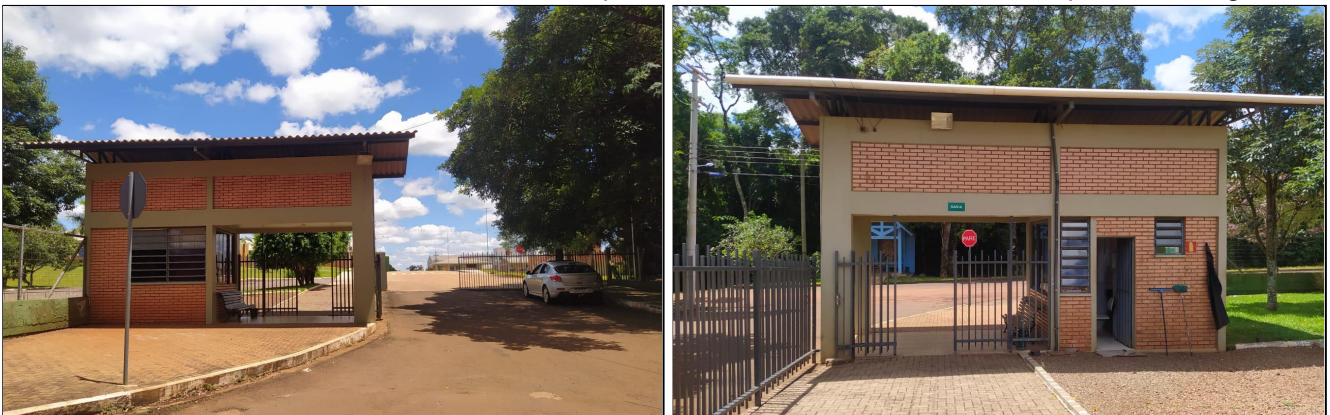
Fotos 31 e 32 - Visão Frontal da Entrada do campus e Vista da Entrada da Guarita Campus Santo Augusto.
