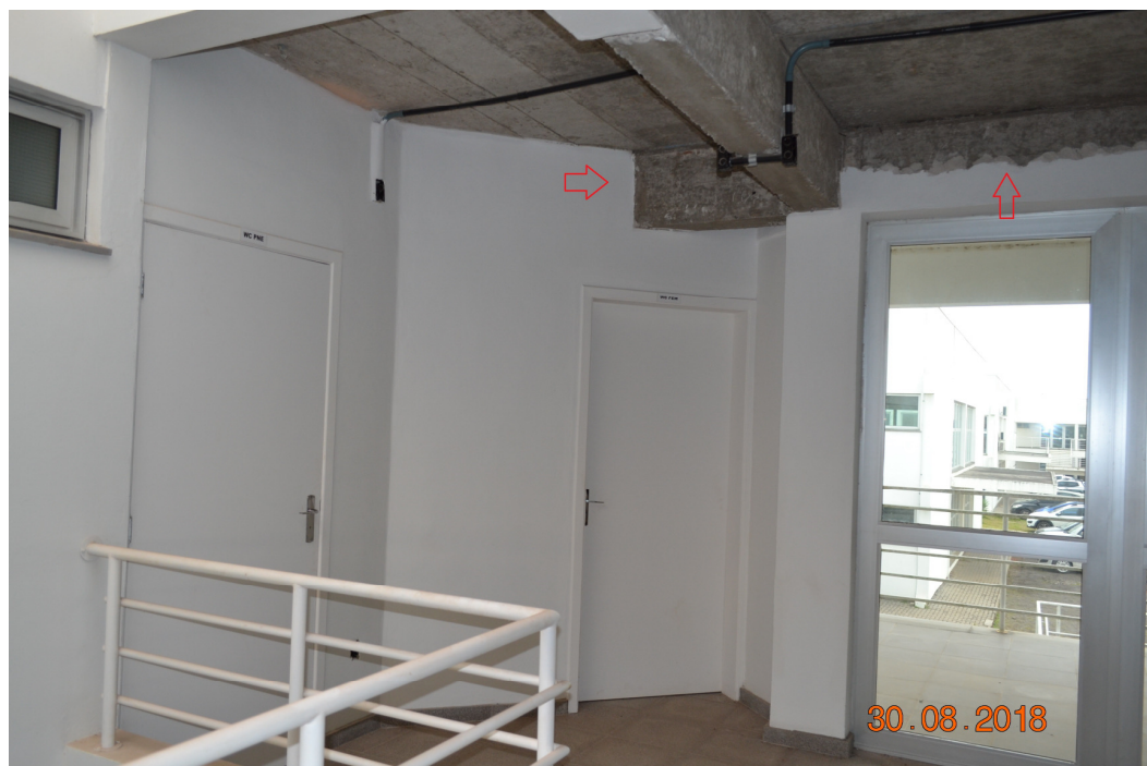
Foto 4 - Nas vigas (onde consta a seta vermelha, por exemplo), aplicar os revestimentos (chapisco e emboço) para que a parede fique toda no mesmo nível e prumo
