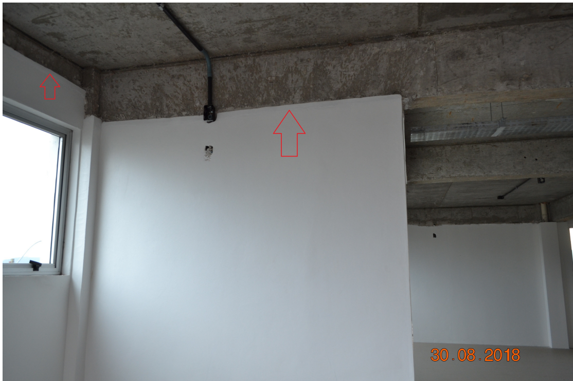
Foto 2 - Aplicar os revestimentos nas vigas (chapisco e emboço) para que a parede fique toda no mesmo nível e prumo
