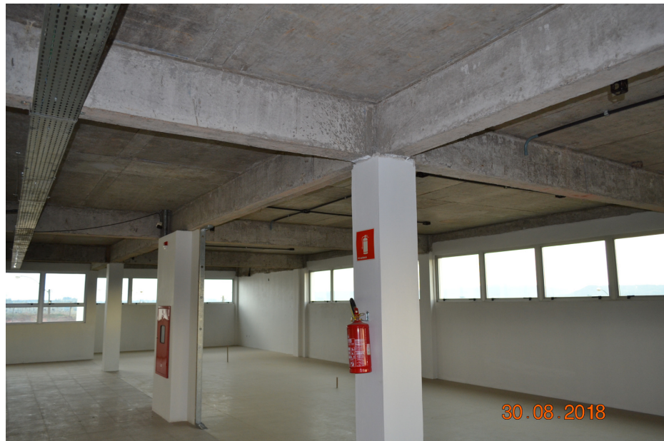
Foto 1 – Vista geral da obra onde demonstra que a obra está parcialmente executada
