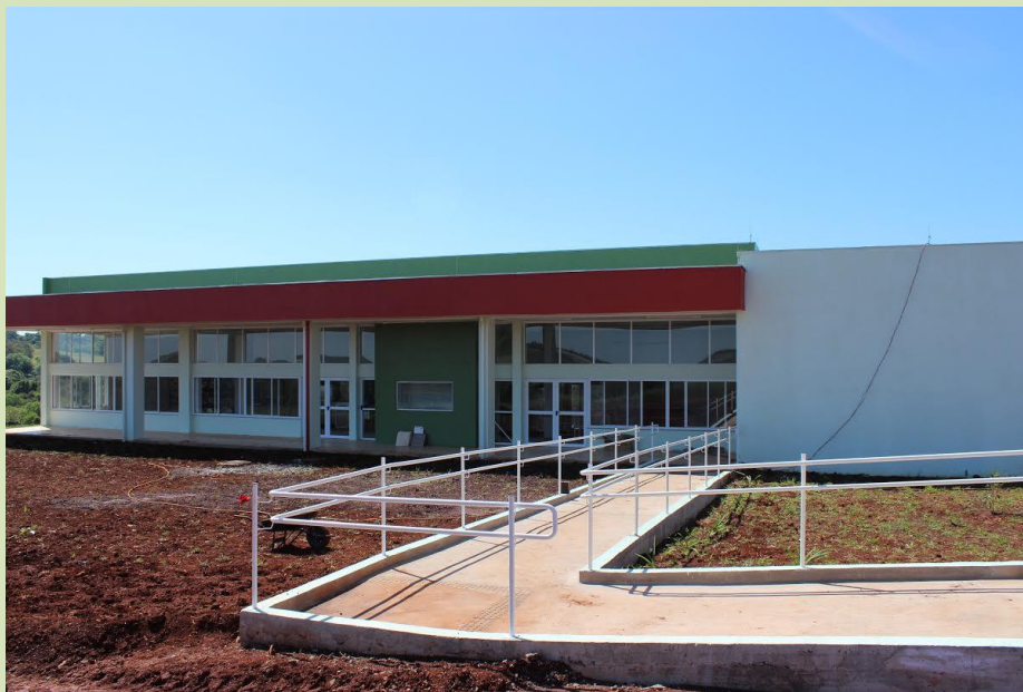
Figura 2: Refeitório com obra em fase final de execução.
